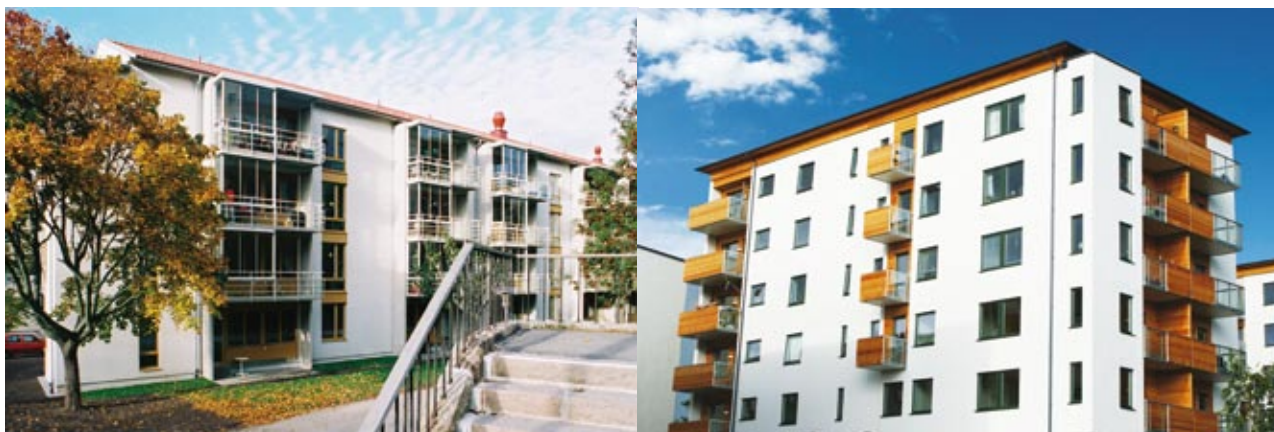
Kvarteret Kanslisilket, Vällingby. Foto: Lindbäcks Bygg AB.
