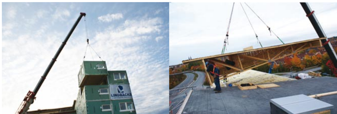
Industriellt träbyggnade, Uppsala. Foto: Lindbäckes Bygg AB.
