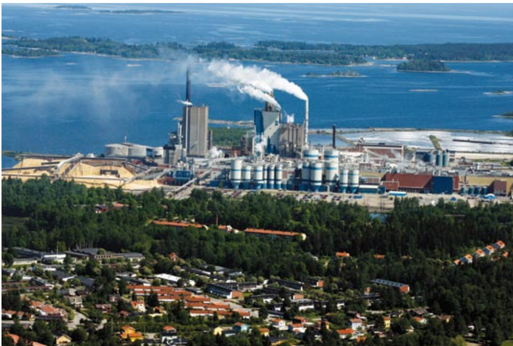
Skogsindustrins långsiktiga råvarubehov har haft stor betydelse för lagstiftningen om ett uthålligt skogsbruk. Korsnäs produktionsanläggning i Gävle tillverkar nyfiberbaserade förpackningsmaterial. Foto Korsnäs AB.
