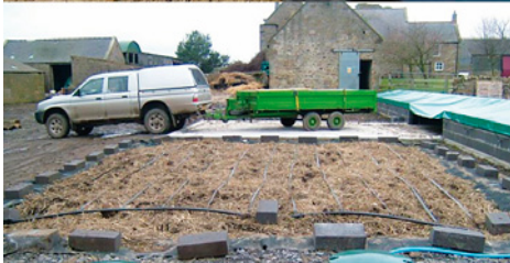
Anläggning av biobädd i Storbritannien.
