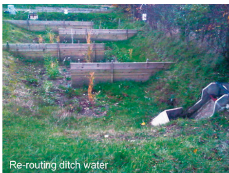
Meandring har skapats på konstjord väg i ett utflöde i Frankrike, för att minska vattnets hastighet.
