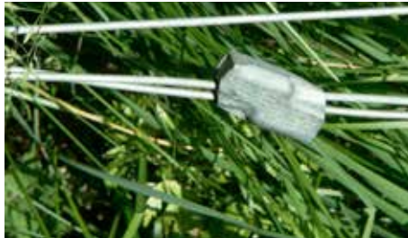
Bild 3. Spänn trådarna hårt med trådspännare eller gripplar. Gripplar är billigast.
