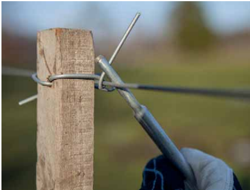
Bild 79 G. Vrid clipset runt tråden ca 2 varv.
