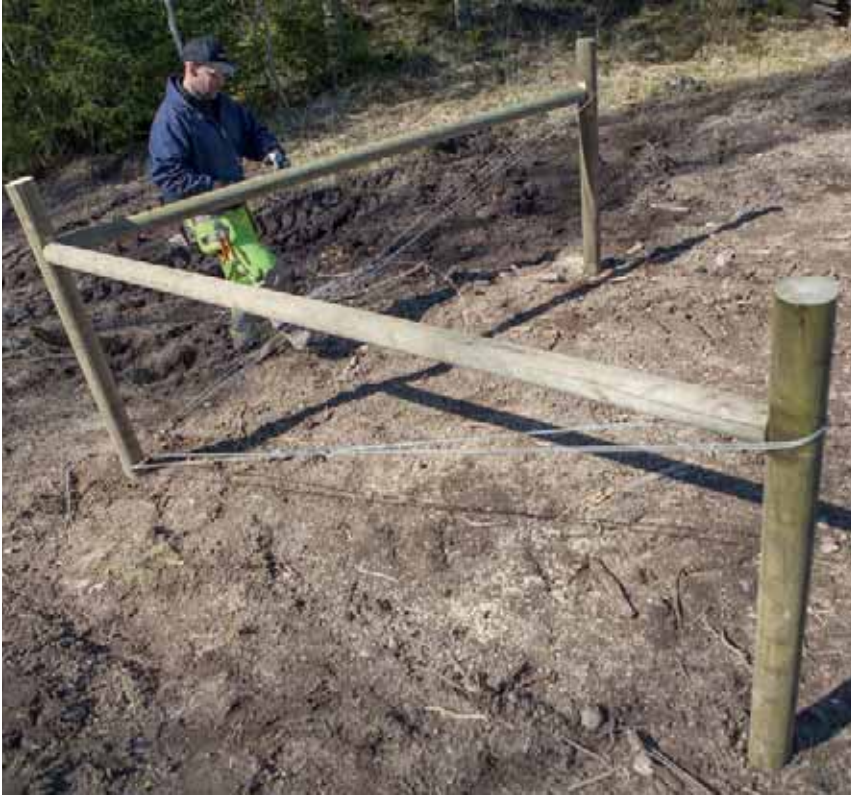
Bild 65. Upprepa proceduren med späntråden vid nästa parallelogram.
