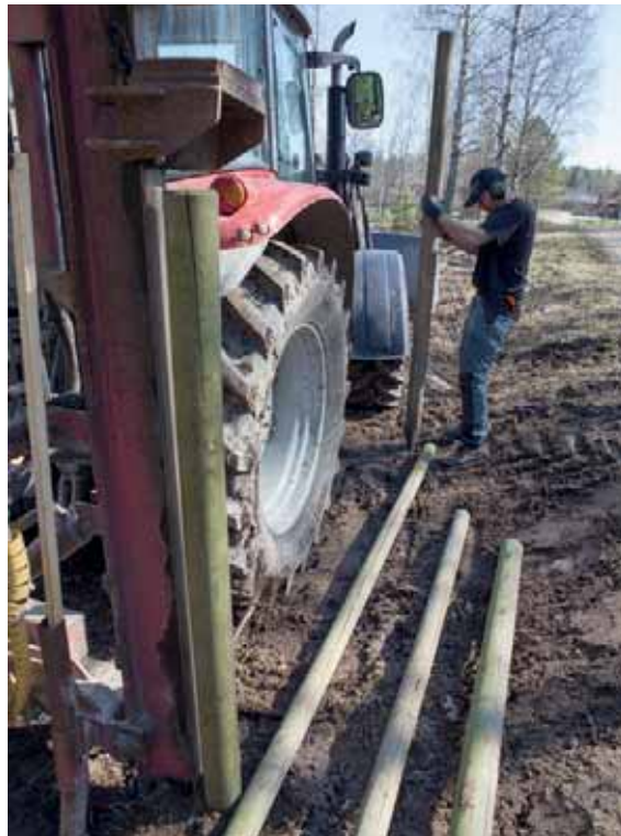
Bild 39. Lägg ut överliggaren på marken från hörnstolpen och ut i stängslets riktning. Sätt stolpen på ett avstånd lite kortare än underliggaren, ca 280 cm från hörnstolpen.
