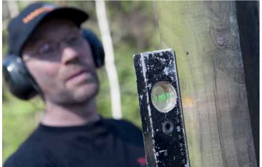
Bild 38. Sträva efter att få stolpen rak. Använd vattenpass.
