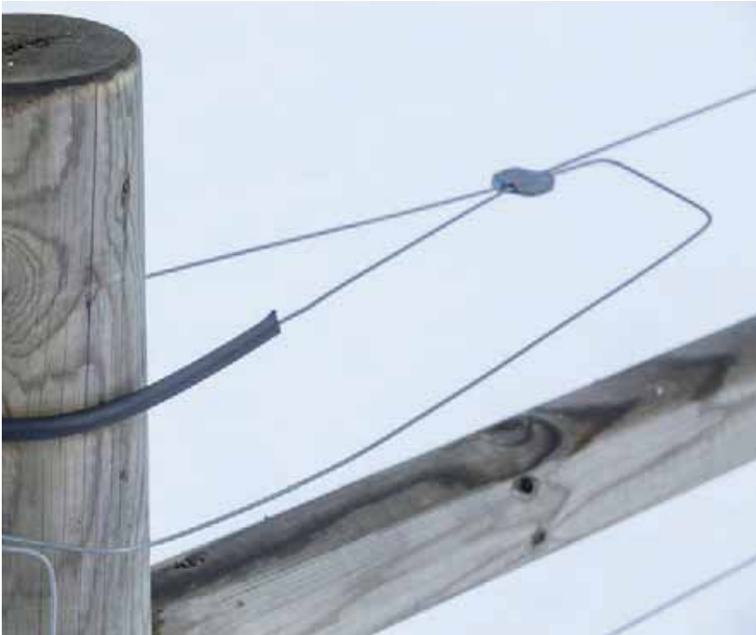
Bild 75. Man kan använda Gripplar istället för att göra egna knutar, men det blir betydligt dyrare.
