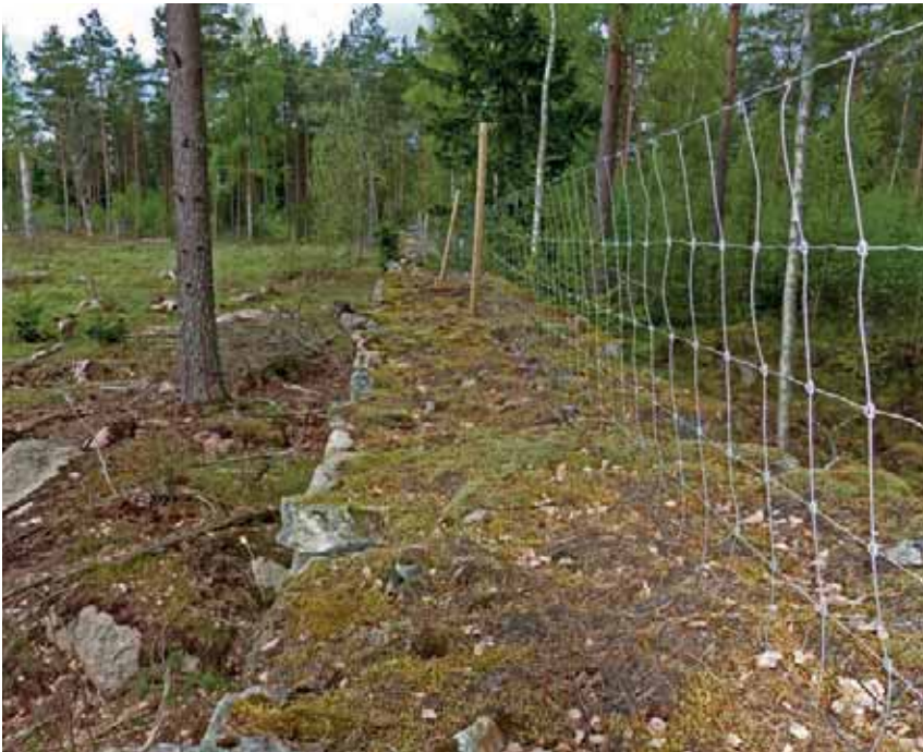
Bild 103. Hög och bred stenvmur med fårnät ovanpå. Observera att nätet behöver kompletteras med eltrådar för att vara rovdjursavvisande.
