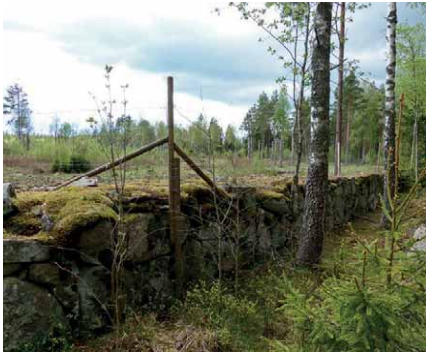
Bild 104. Hörn av fårnät vid stenmur. Observera att nätet behöver kompletteras med eltrådar för att vara rovdjursavvisande.
