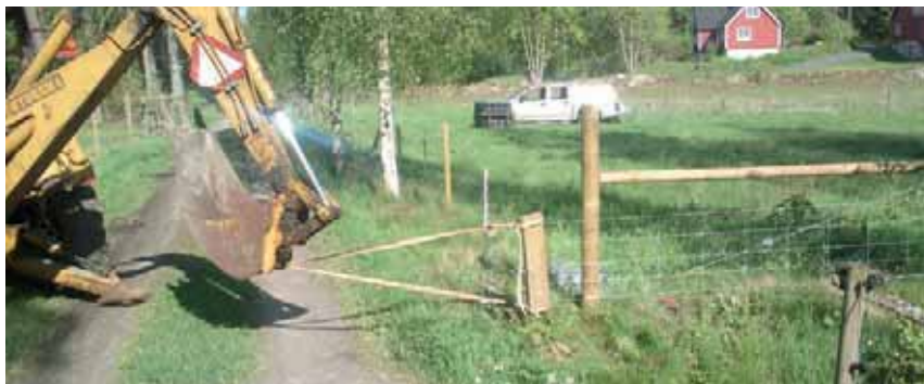
Bild 87. Sträckning av nät med maskin. Obs! Dra inte för hårt!
