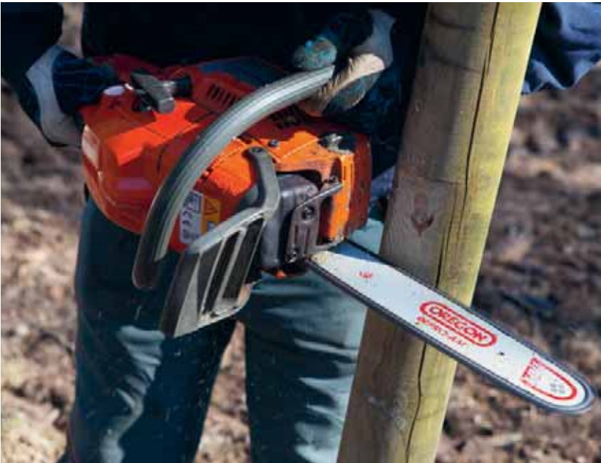
Bild 46. Såga ur lite kring markeringen på stolpen med motorsåg, fogsav eller yx/kniv. Fäll in överliggaren på platsen. OBS! Montörens vänstertumme ska hållas ner runt motorsågsbågen.
