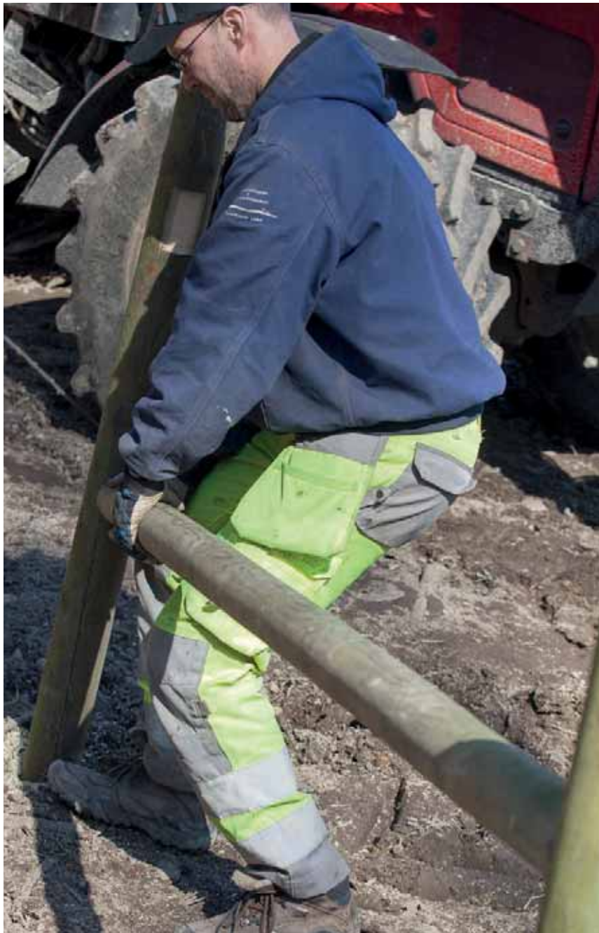
Bild 49. Sätt överliggaren på plats.
