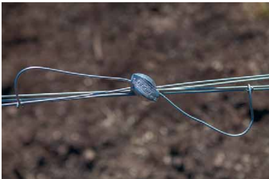
Bild 63. Naja fast ändarna på tråden, se s 80.
