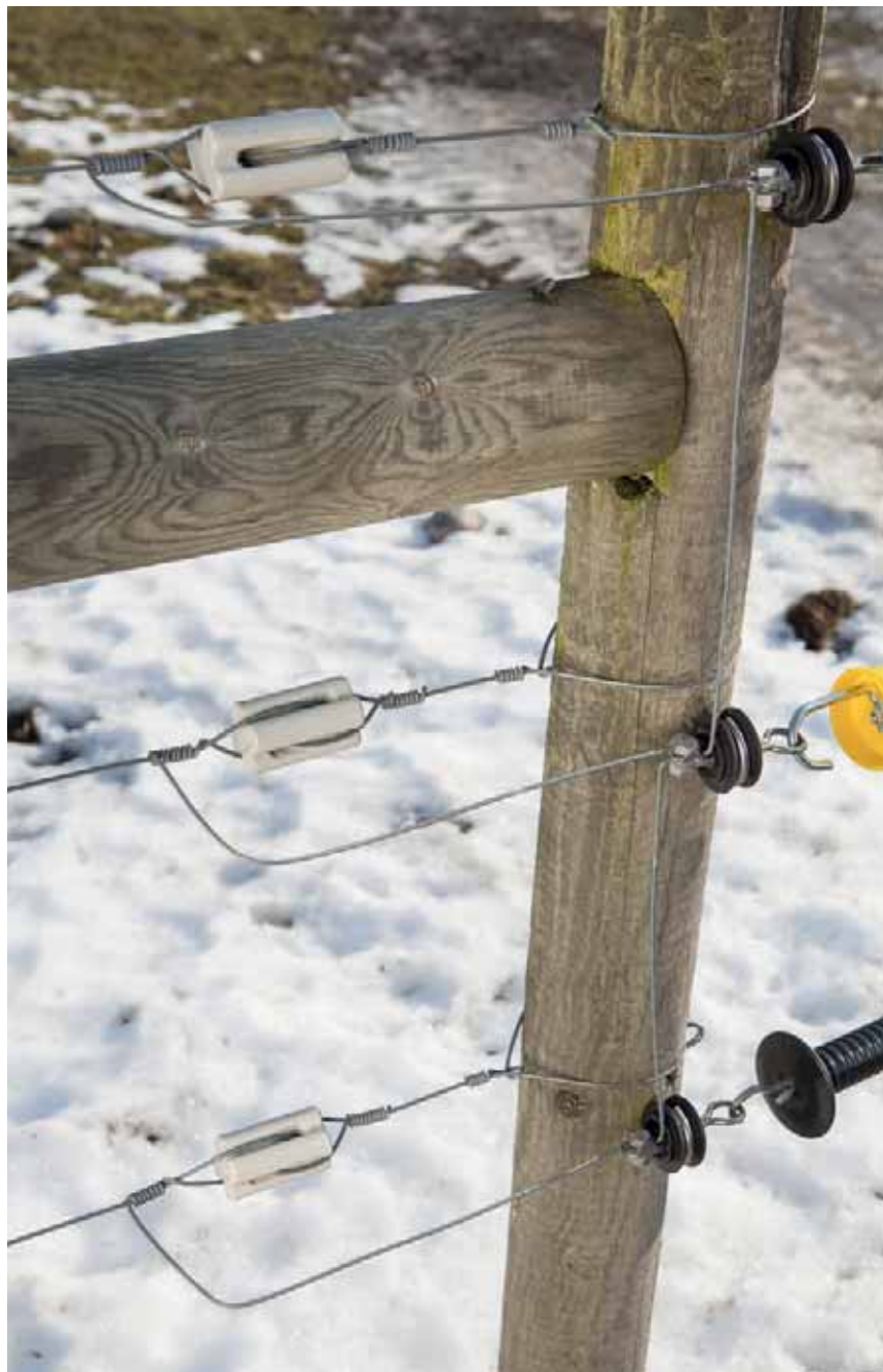
Bild 83. Vidarekoppling av strömtrådarna vid grindankare.
