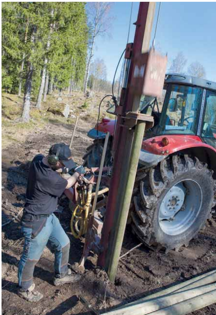
Bild 37. Slå ned hörnstolpen med stolpnedslagare.
