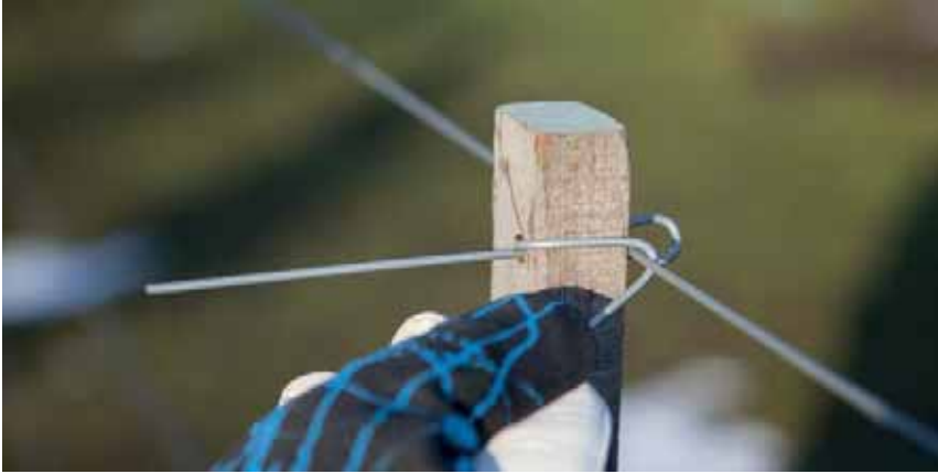
Bild 79 D. Böj clipset på vardera sidan stolpen på ovansidan om tråden.
