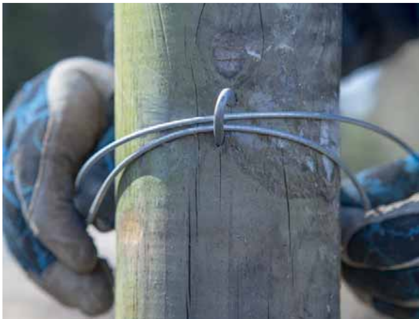
Bild 60. Rätta till trådarna så att de ligger parallellt med varandra.
