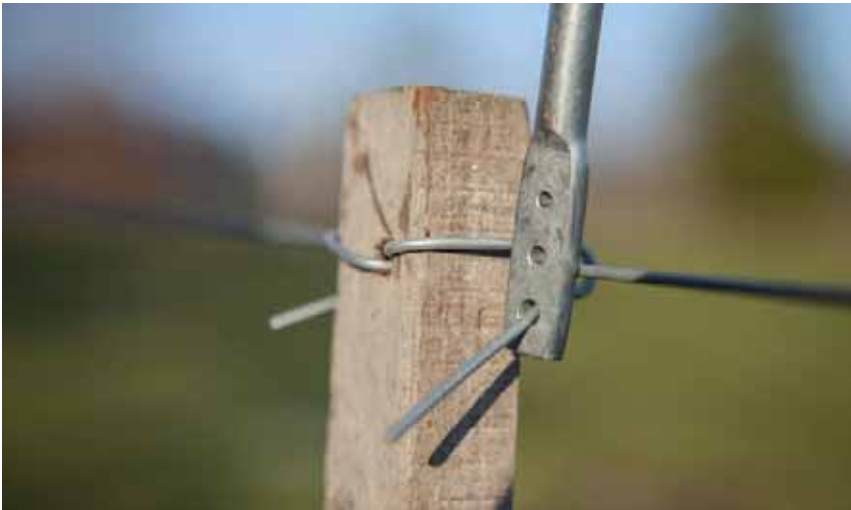
Bild 79 F. Trä på verktyget i det mellersta eller yttersta hålet och vrid runt tråden.
