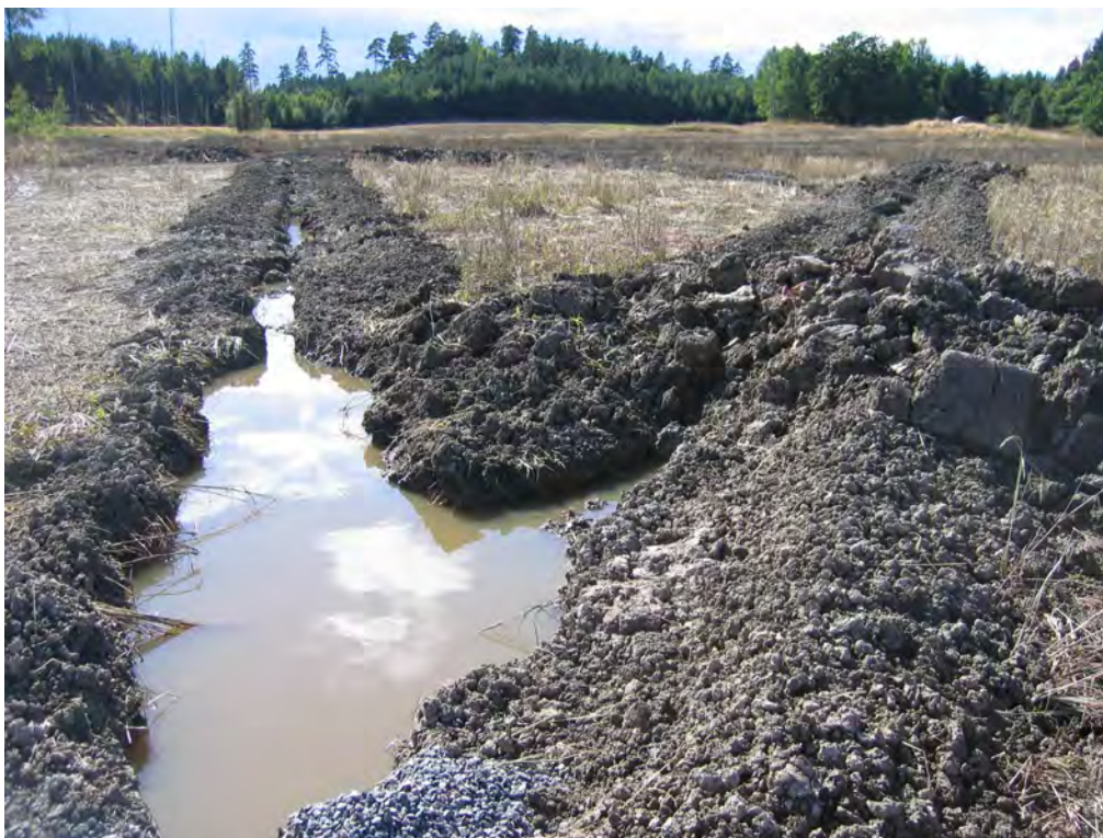
Bild 9. Hösten 2012 var blöt och regnig, vilket ställde till stora problem och gjorde att förhållandena för att täckdika och anlägga kalkfilterdiken blev allt annat än optimala. Foto: Anuschka Heeb
