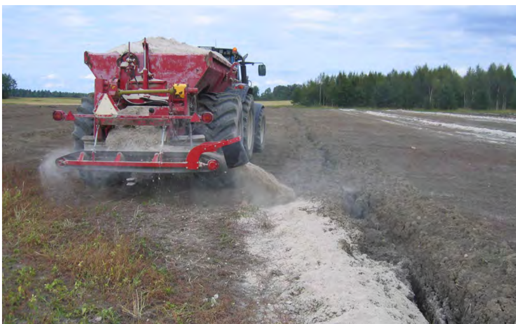
Bild 7. Spridning av kalk vid anläggning av kalkfilterdike. Foto: Anuschka Heeb
