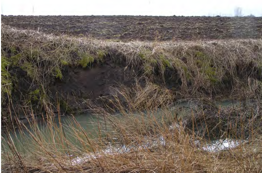
Bild 15. Del av den öppna bäckfåran i område N33 i Halland. Skyddszoner saknas här och en del jord har eroderat i dikesslätten. Foto: Katarina Kyllmar
