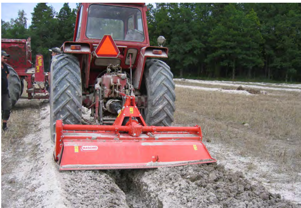
Bild 8. Kalken blandas in i återfyllnadsmaterialet med hjälp av en fräs. Foto: Anuschka Heeb
