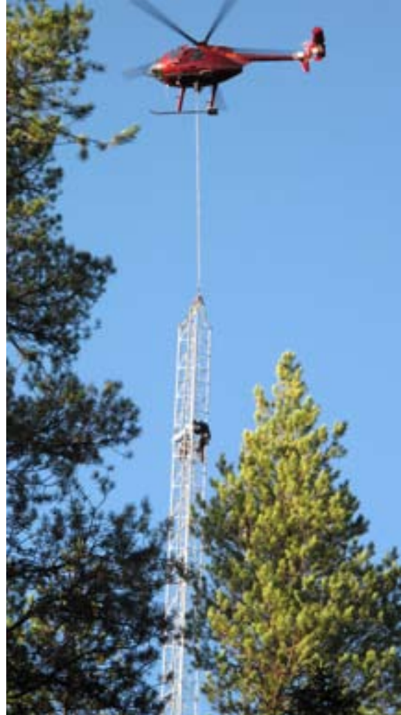
I oktober lyftes mätstationen Svartbergets 150 meter höga mast på plats av helikopter.
