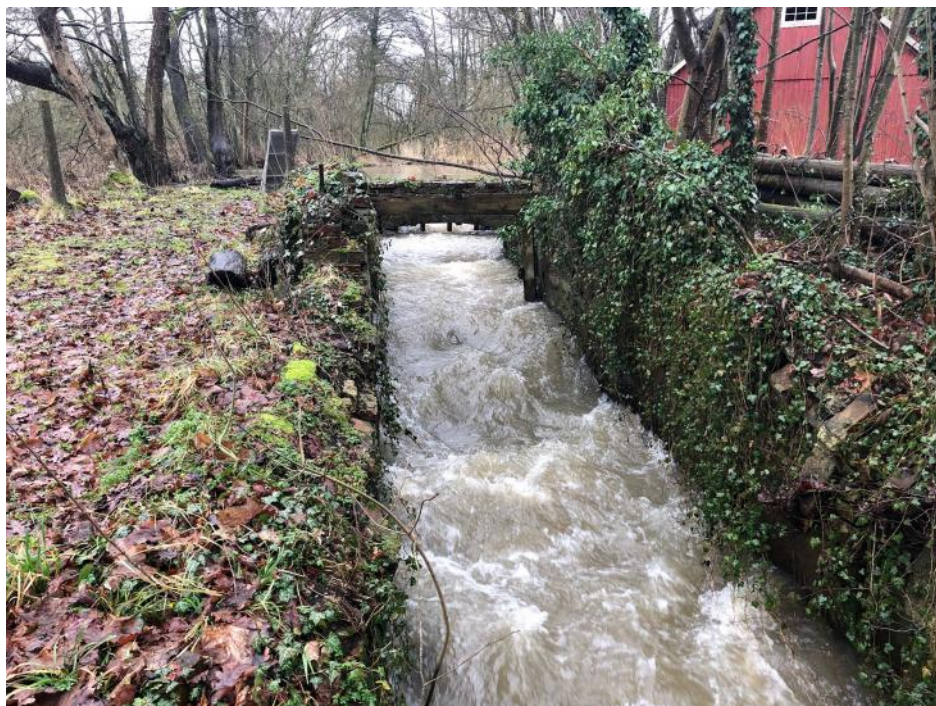
Figur 8. Bild som visar kvarnrännan uppströms räknaren med utskov och galler som reglerar inflödet till kvarnrännan.
